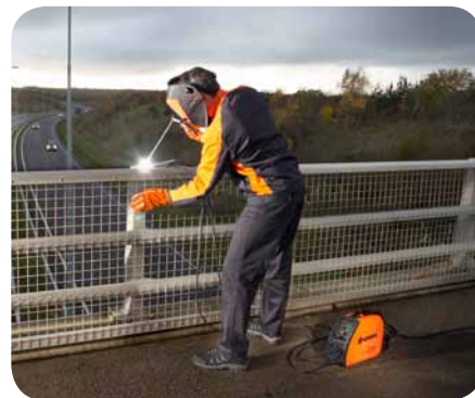
Качественная сварка независимо от места ее проведения
